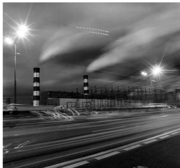
Москва. Электростанция в районе Кольцевой дороги © PANOS/Мартин Роемерс
